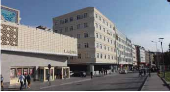
Kayseri Meydan Cephe Yenileme Projesi
