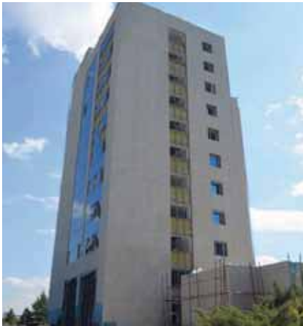
Gıda ve Tarımcılık Bakanlığı Ek Hizmet Binası Yüklenici: Temelsen Yapı Enerji San Ltd. Şti. Ürün: Wallmerk Nanothermal Plus
