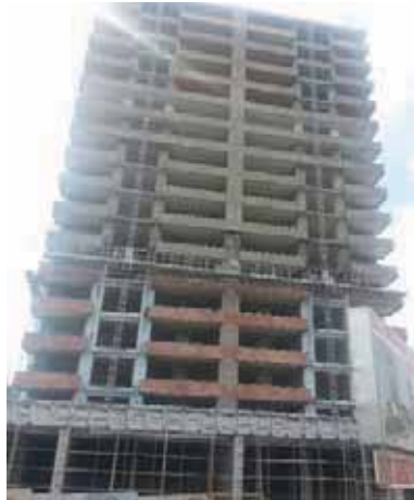
Sarıtaş Konutları Yüklenici : EBS İnşaat Ürün: Wallmerk Fassade Extreme
