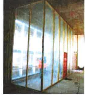
Şekil 1 Bir binanın inşaat sırasında bir bölümünün test edilmesi [3]
