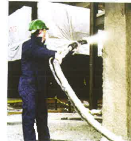
püskürtme taşyünü ile yangın yalıtımı
