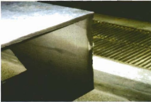
Hava Kanalında Akustik Sünger Uygulaması
