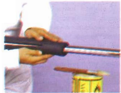
Şekil 3. Yapıştırma işlemi kenarlardan ortaya doğru olmalıdır.
