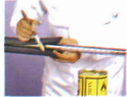
Şekil 2. Yapıştırıcının ek yerlerine sürülmesi
