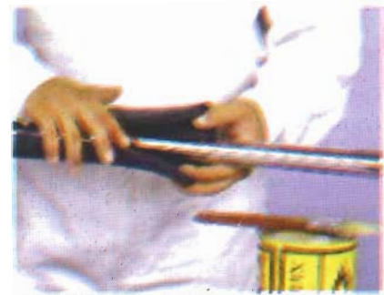
Şekil 4. Yapıştırıcı sürüldükten sonra yüzeylerin parmakla kontrolü
