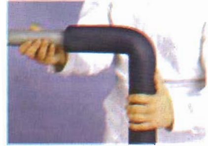
Şekil 1. Elastomerik Kauçuk Köpük malzemenin bir ucu açık boruya itilerek geçirilmesi
