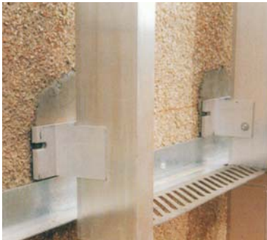
Resim 1: delikli metaldeki malzeme yangın anında şişerek alev ve duman geçişini engeller.
