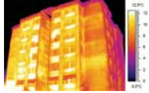
Yalıtımsız duvar ve pencere
