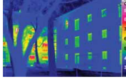
Yalıtımsız Bina ve Pasif Ev'in termal kamera karşılaştırması.
