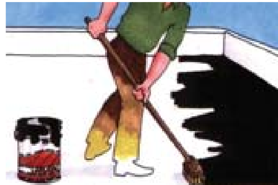
Şekil 4: Betonarme yüzeylerin bitüm ile astarlanması
