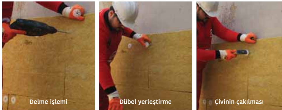
Şekil 2. Geleneksel çelik/plastik çivili dübel uygulaması
