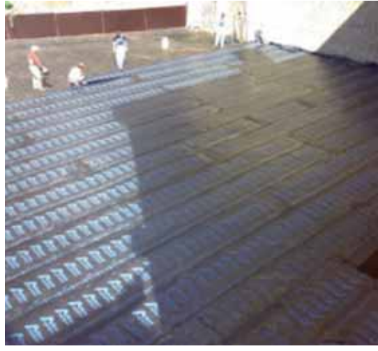
Şekil 2. Radye temel bohçalama uygulaması
