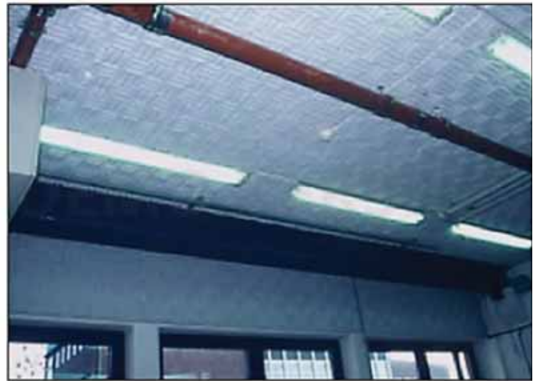
Şekil 4. Yüzeyi pürüzlü melamin reçine köpük ürünlerinin duvar ve tavana doğrudan uygulanması
