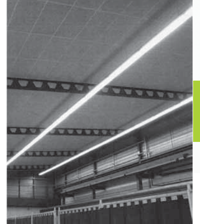
Resim 2. Bir tesisat katında kullanılan taşıyıcı akustik paneller
