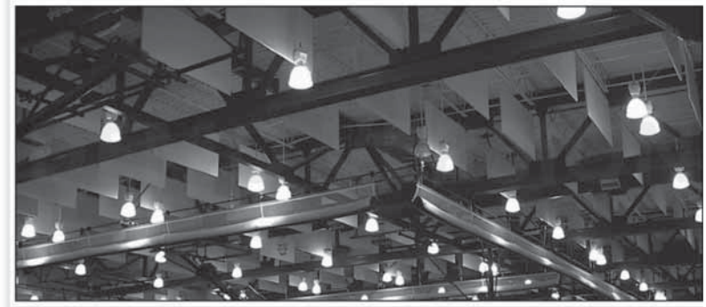
Şekil 3. Bir atölye alanı üzerinde ses yutucu panoların kullanımı
