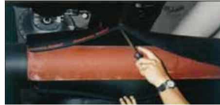
Resim 5: 20 yıllık kullanımdan sonra dahi fiziki özelliklerini ve boruyu koruyan Armocell yalıtımı
