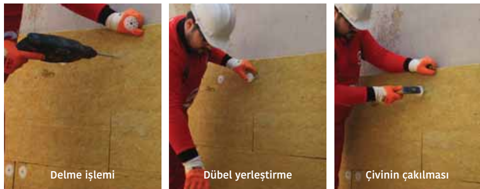
Şekil 2. Geleneksel çelik/plastik çivili dübel uygulaması
