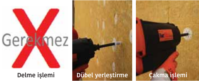
Şekil 3. Tabanca Çakma Dübeli uygulaması (TÇD)
