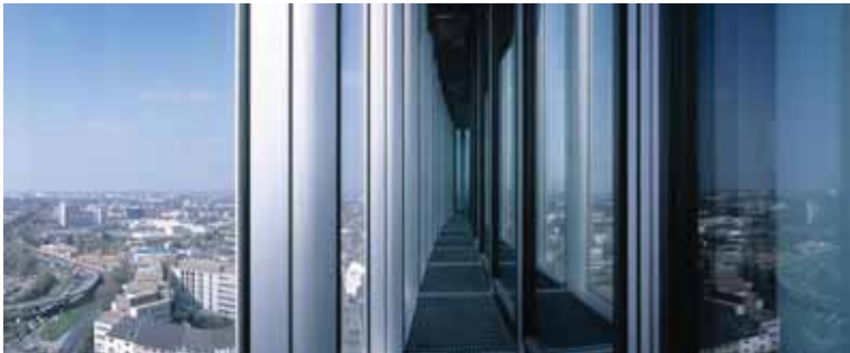
Şekil 2. Şaft kutu tipi çift kabuk cephe detayı, ARAG 2000 Kulesi [3]
