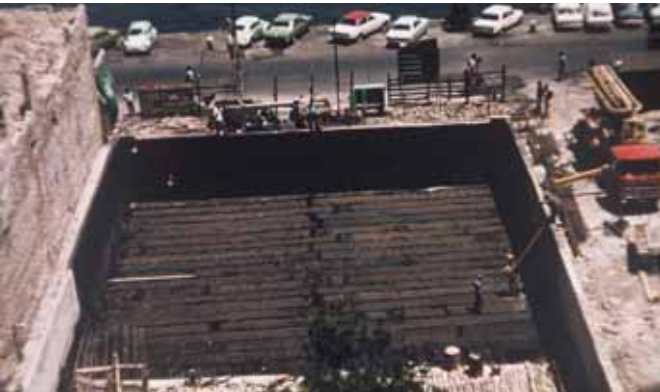
Anadolu Sigorta İzmir 1977, okside bitümlü örtülerle yapılan deniz seviyesinin 4 m altına girilen su yalıtımı.
