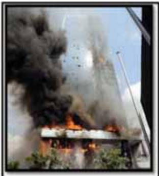
Polat Tower Yangını
