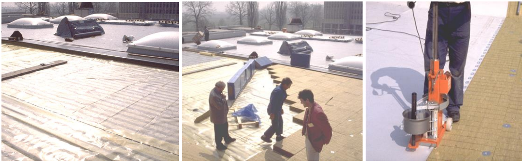
Resim 36: Hafif metal çatı detayı uygulama adımları
