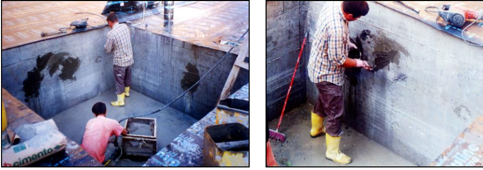
Resim 16: Basınçlı suyun durdurulması amaçlı yapılan su yalıtım malzemesi uygulaması
