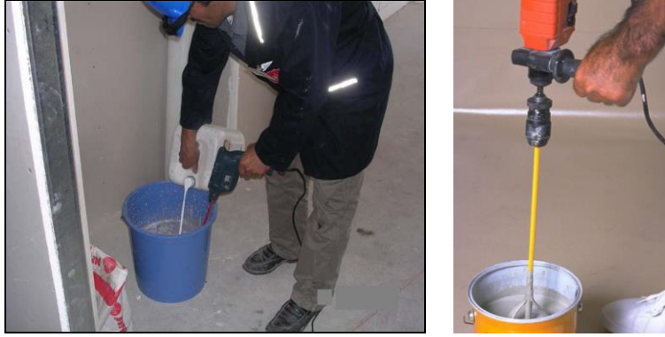
Resim 31:Çimento esaslı elastik su geçirmez yalıtım malzemesinin hazırlanması
