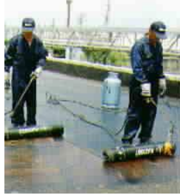
Resim 2: Polimer esaslı su yalıtım malzemesinin yüzey üzerine serilmesi
