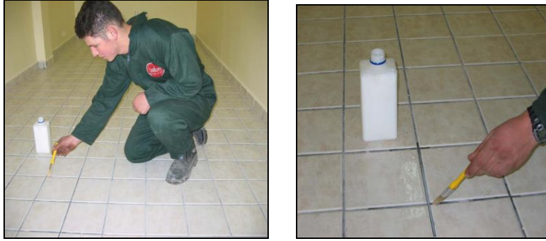
Resim 33: Derz aralarına yalıtım malzemesinin sürülmesi
