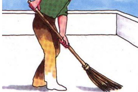
Resim 6: Yüzeylerin temizlenmesine özen gösterilmelidir
