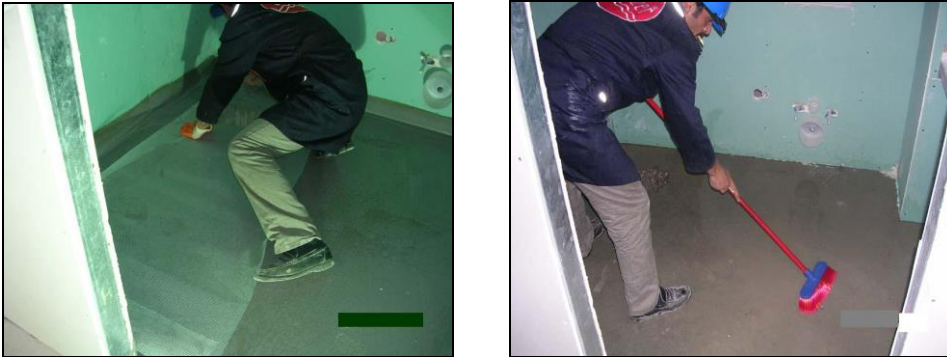
Resim 32: Zemine çimento esaslı yalıtım malzemenin sürülmesi
