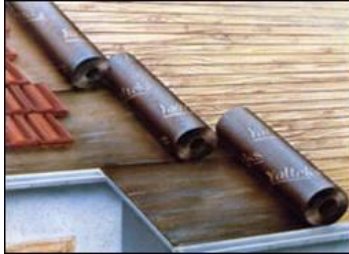
Resim 4: Kiremit altı örtüsünün döşenmesi
