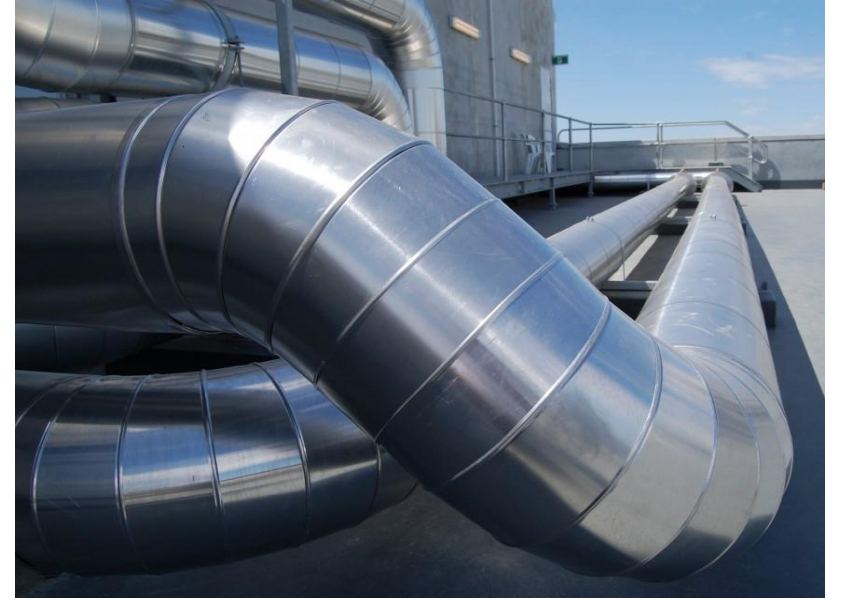
Düşük ısı transfer katsayısı ( 5 \text{ W/m}^2\cdot\text{K} ) Emissivite ( \epsilon ) = 0.05
