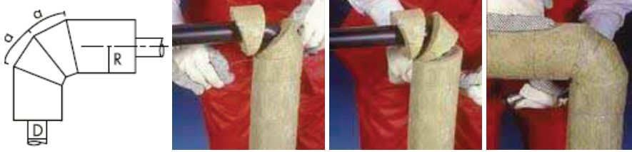
Şekil 43: Prefabrik yalıtım malzemeleri ile dirsek yalıtımı
