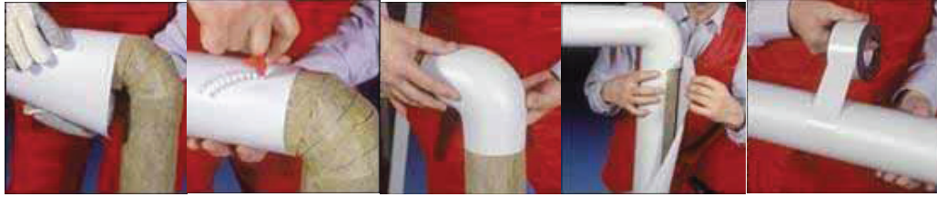
Şekil 44: Yalıtım malzemesinin üzerine son kat kaplama uygulanması
