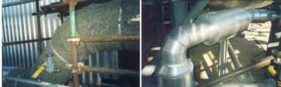
Şekil 64: Rabbitz telli taşıyıcı şiltelerle borularda ısı yalıtımı
