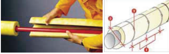
Şekil 42: Prefabrik yalıtım malzemeleri ile uygulama
