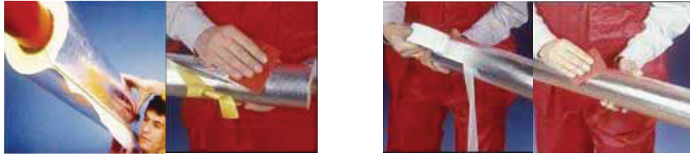
Şekil 40: Kendinden yapışkanlı ek yeri olan/olmayan boru yalıtım malzemeleri ile uygulama
