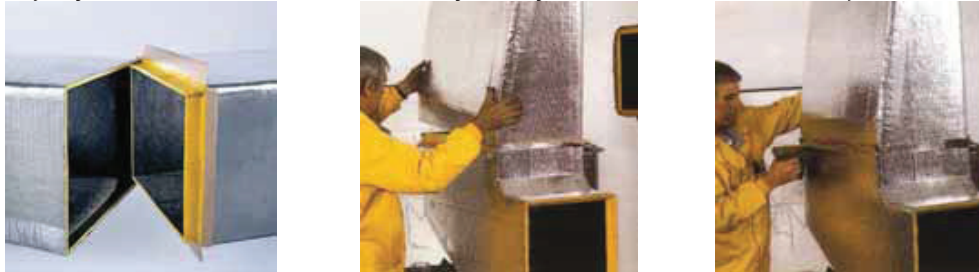
Şekil 34: Kanalların montajı ve birleşme yerlerinin zımbalanması
