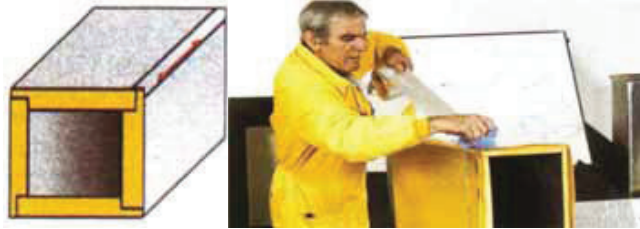
Şekil 33: Kanalların birleşme kenarlarında alüminyum folyo bant uygulaması
