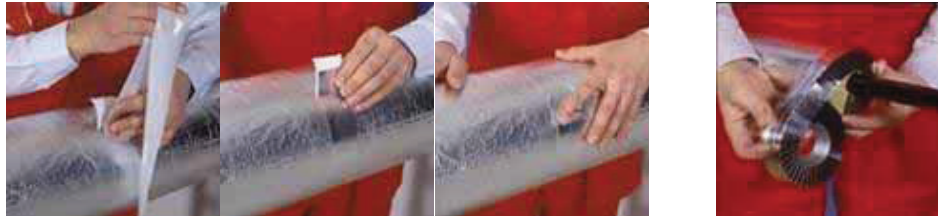
Şekil 41: Enine ek yerlerine alüminyum folyo bant uygulaması ve tesisat bitişleri
