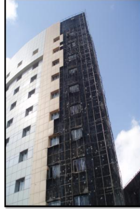
(Gaziosmanpaşa Devlet Hastanesi Yangını)
