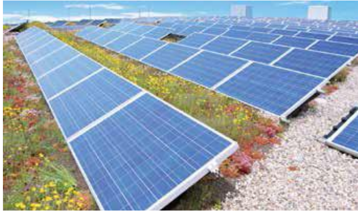
Resim 2. Seyrek Bitkilendirilmiş Çatı Üzerine Fotovoltaik Panellerin Yerleştirilmesi.
